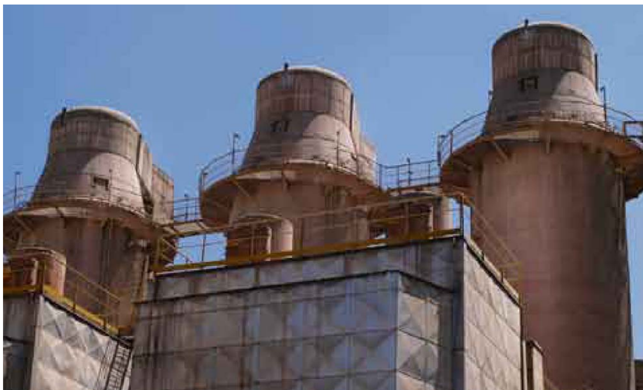
Robilante, Italia: le 3 torri di condizionamento e rispettivi elettrofiltri del forno 3 Robilante, Italy: the 3 conditioning towers and associated precipitators of kiln 3
